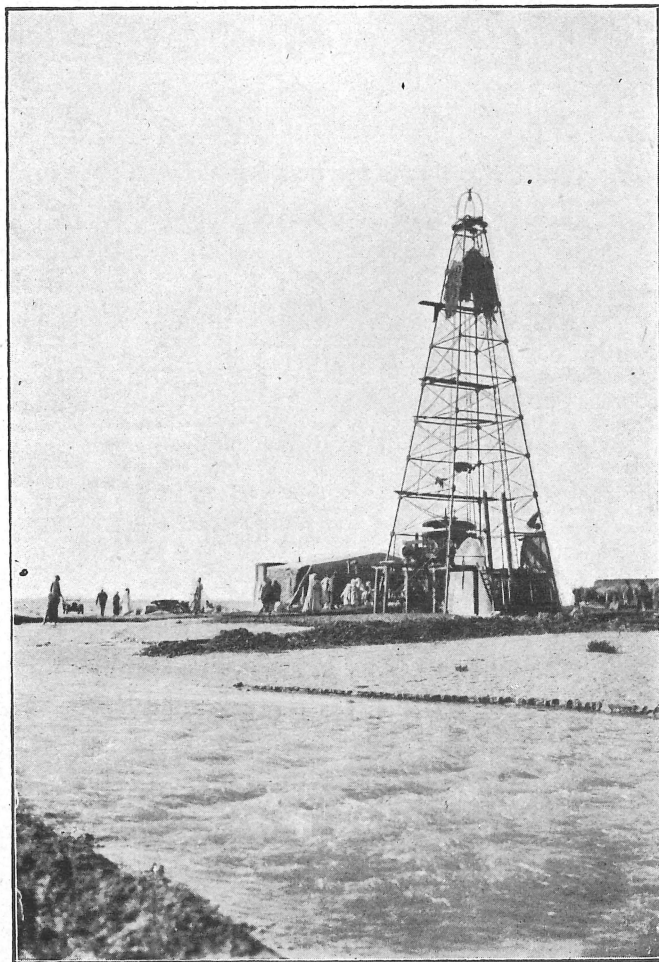
Sondage de Mraïer. — Débit de 42.000 litres à la minute.
