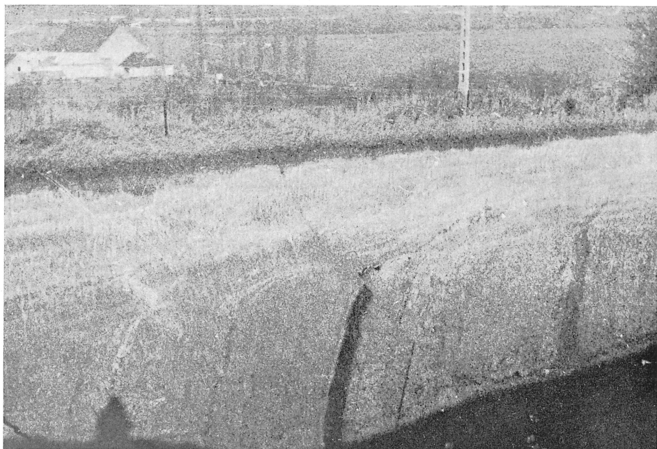
Fig. 6. — Carrière du Ruau à Monceau/s/Sambre. Phénomène de fauchage dans le haut des bancs de schistes avec veines de houille et étirement des limons de pente vers le bas du versant, vers le Piéton (à droite de la photo). Pente de 2° puis 3°.
