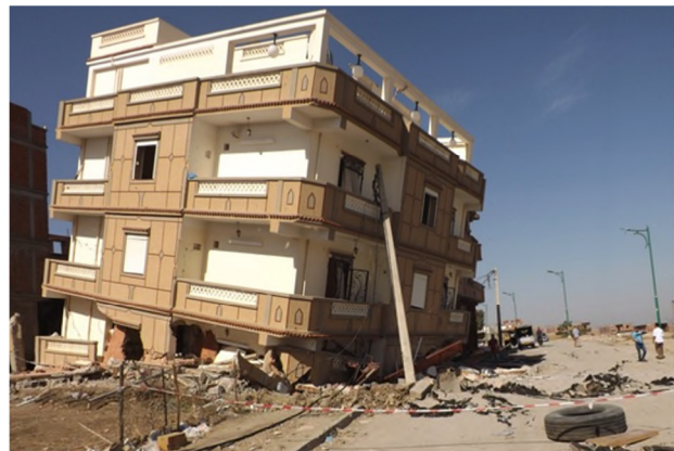
Fig. 12 : a- Maison effondrée située dans la continuité du long cisaillement. b- basculement de la construction provoquant la déformation de la chaussée.
