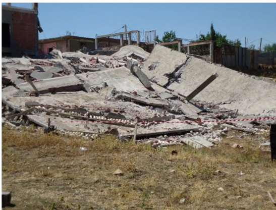
Fig. 12 : a- Maison effondrée située dans la continuité du long cisaillement. b- basculement de la construction provoquant la déformation de la chaussée.
