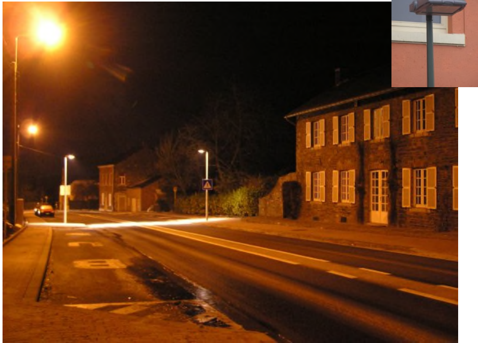
Figure 4 : Les 2 lampadaires (modèle à verre plat, voir image en encart) qui éclairent le passage pour piétons jouent parfaitement leur rôle : seul le passage est éclairé, presque aucune lumière n'est émise horizontalement ni vers le haut (mais pourquoi laisser ces lampes allumées toute la nuit : un simple bouton poussoir permettrait de les allumer sur demande et d'économiser tellement d'énergie !) Par contre, les lampadaires de gauche, du type installé au bord de la plupart des routes, sont éblouissants, éclairent les façades (intrusion dans la vie privée, voir la façade de la maison) et envoient une partie de la lumière vers le ciel (Plainevaux, Grand-Route). Photo Ph. Demoulin.
