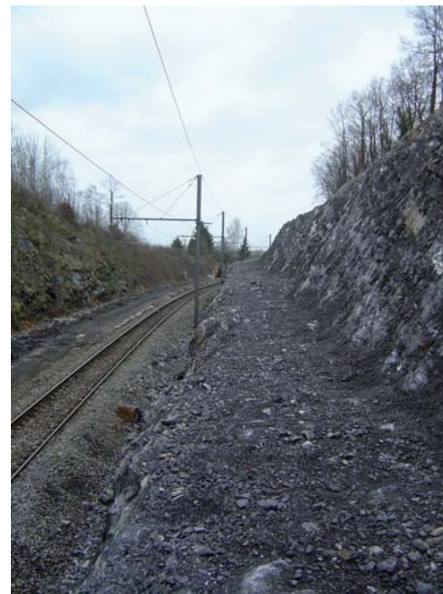
Figure 6. Marche-en-Famenne: stabilisation de parois dangereuses le long d'une ligne SNCB. Situation avant travaux (2004) et après travaux (2007).
