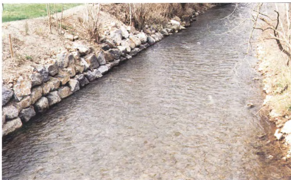
Photo 2 : L'Aisne site « carrière » au printemps 1998 après des travaux de réfection d'un pont. Radier transversal uniforme où l'étude a été réalisée en fin 1998-début 1999.
