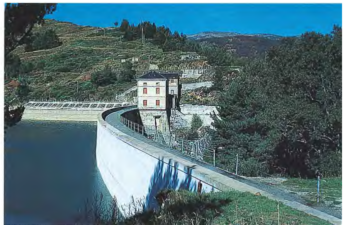
Photo 2. Le barrage du Puy Valador
