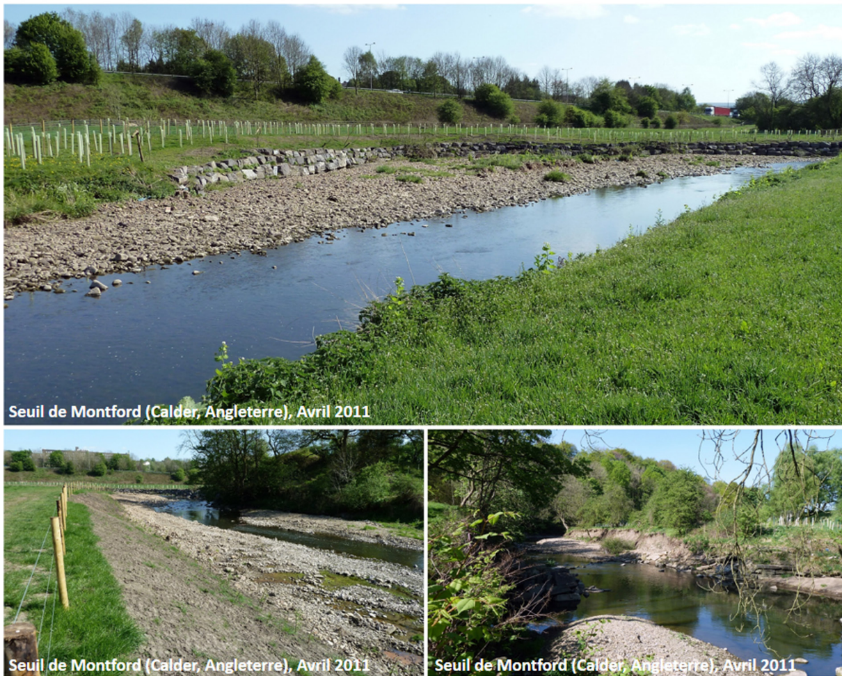
Figure 5. Site du seuil de Montford sur la rivière Calder (Lancashire, Angleterre). Vues de l'ancienne zone sous influence de l'ouvrage (amont en haut (vue de l'amont); aval en bas (vue de l'aval) et de l'ouvrage arasé dont on observe les vestiges sur les deux berges (en bas à droite, vue depuis l'aval). Arasement de l'ouvrage en travers (conservation des murs bajoyers) et reconfiguration du chenal (reprofilage des berges, ensemencement sur géotextile, enrochements dans les rives concaves, aménagement d'une clôture en rive gauche, plantations en fond de vallée en rive gauche)
