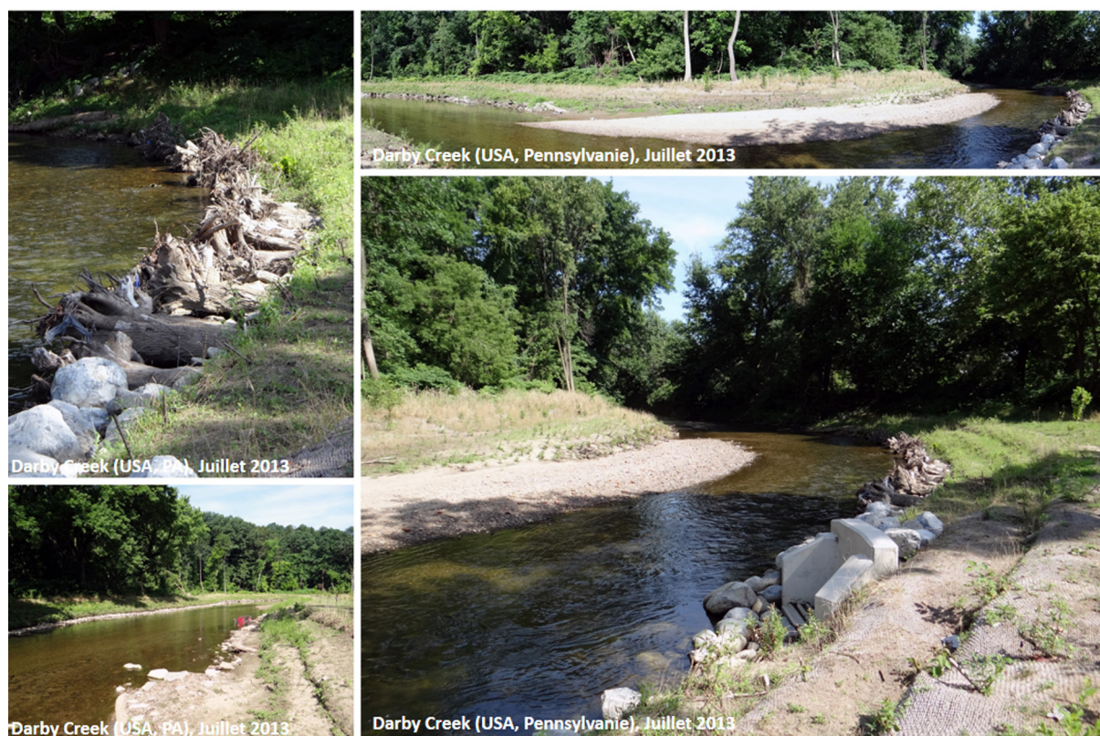
Figure 6. Seuil de Darby Borough effacé sur la Darby Creek (Etats-Unis, PA). Vue sur les espaces sous influence de l'ancien ouvrage : à l'aval immédiat de l'ancien ouvrage (vue depuis l'aval) en bas à gauche ; plus à l'amont, vue d'ensemble en haut à droite et détails des aménagements en haut à gauche et en bas à droite. Accentuation de la sinuosité du tracé, berges reprofilées et stabilisées (enrochements et dépôt de troncs dans les rives concaves), plantations d'arbres et arbustes dans la plaine alluviale, aménagement de pelouses dans le lit majeur)
