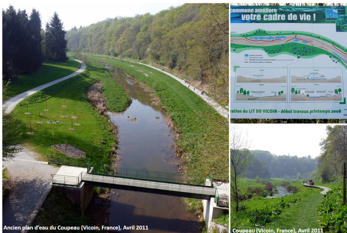
Figure 8. Site du plan d'eau du Coupeau sur le Vicoin (Mayenne, France). Vue d'un panneau de présentation du projet (en haut à droite), vue depuis l'aval au niveau de l'ancien ouvrage de l'espace dénoyé et vue de détail plus à l'amont en bas à droite. Arasement de l'ouvrage en travers (remplacé par une passerelle en hauteur) et reconfiguration du chenal (création de petits seuils, reprofilage et stabilisation des berges) et de la plaine alluviale (plantations d'arbustes, création d'annexes hydrauliques, installation de platelages auprès des annexes hydrauliques, aménagement d'un sentier dans le lit majeur, aménagements récréatifs)
