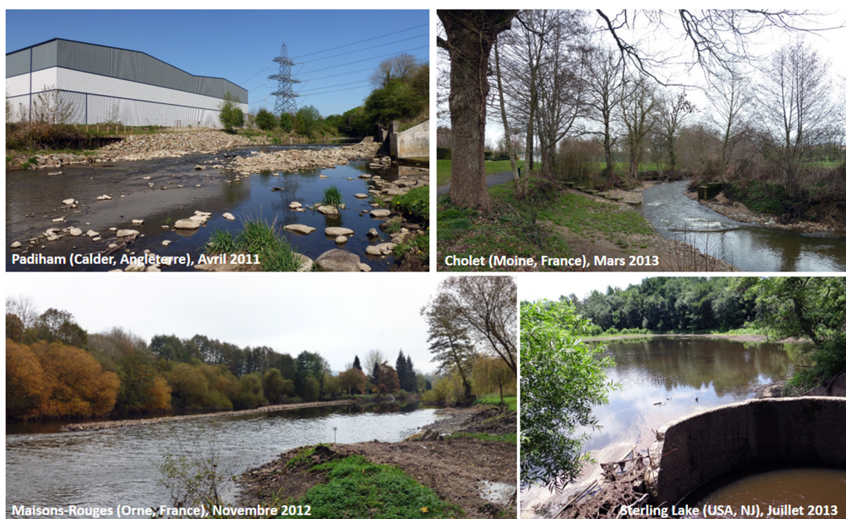
Figure 3. Photographies d'opérations de restauration de la continuité écologique de type ponctuelles : arasement de l'obstacle en travers avec conservation des murs bajoyers (Padiham, vue de l'aval, et Cholet, vue de l'amont), opérations plus complexes (Maisons Rouges, vue de l'aval) et simple brèche (Sterling Lake). Dans tous les cas, l'opération concerne le site hydraulique (chenal et ses berges au lieu de l'ouvrage) et on observe la libre évolution hydrogéomorphologique du chenal sur la zone d'influence de l'ancien ouvrage et à l'aval
