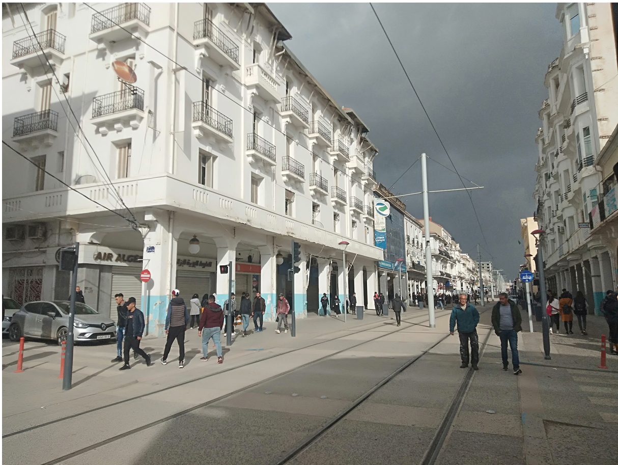
Figure 5. Avenue du 8 mai 1945 après le projet du tramway. Source : Aureur, 2021.
