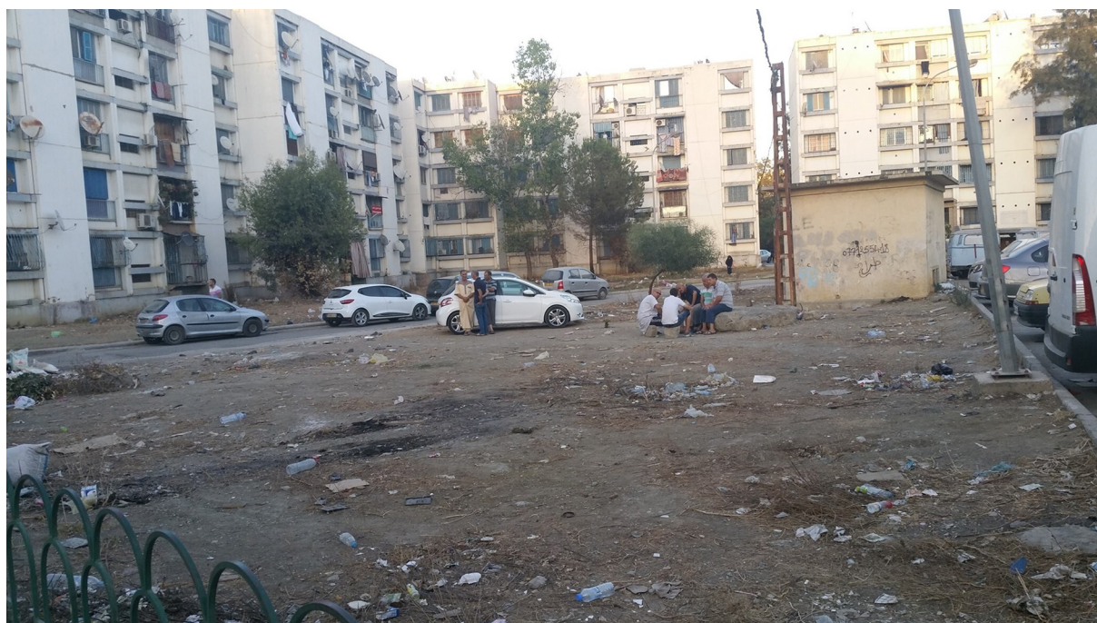
Photo 4. Les espaces extérieurs sont très faiblement appropriés par les résidents, d'où les déchets qui jonchent le sol. Pourtant, de petits groupes s'y réunissent, preuve de l'existence d'un besoin. Cité 05 Juillet à Bab Ezzouar (Auteur 2016)
