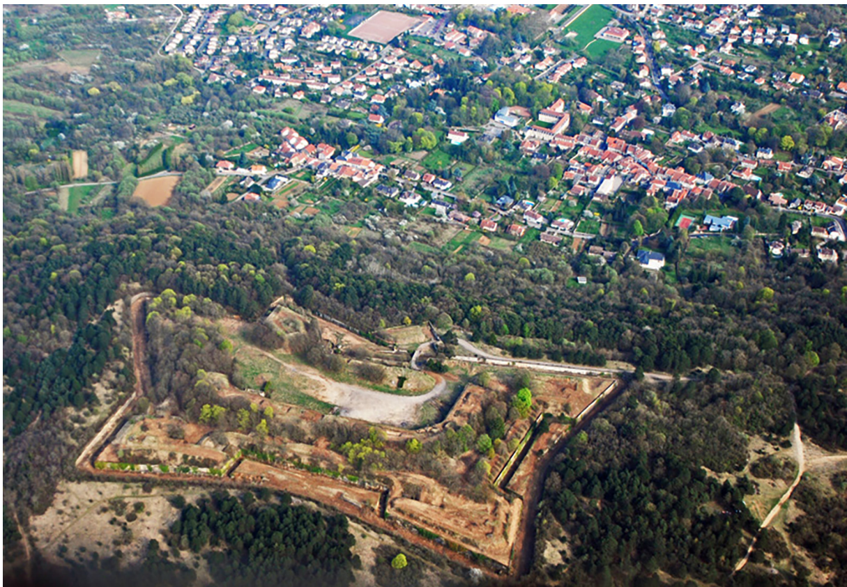
Figure 11. Le Fort de Plappeville sur les hauteurs des Côtes de Moselle, photographie A. Humbert-CERPA, 2009.
