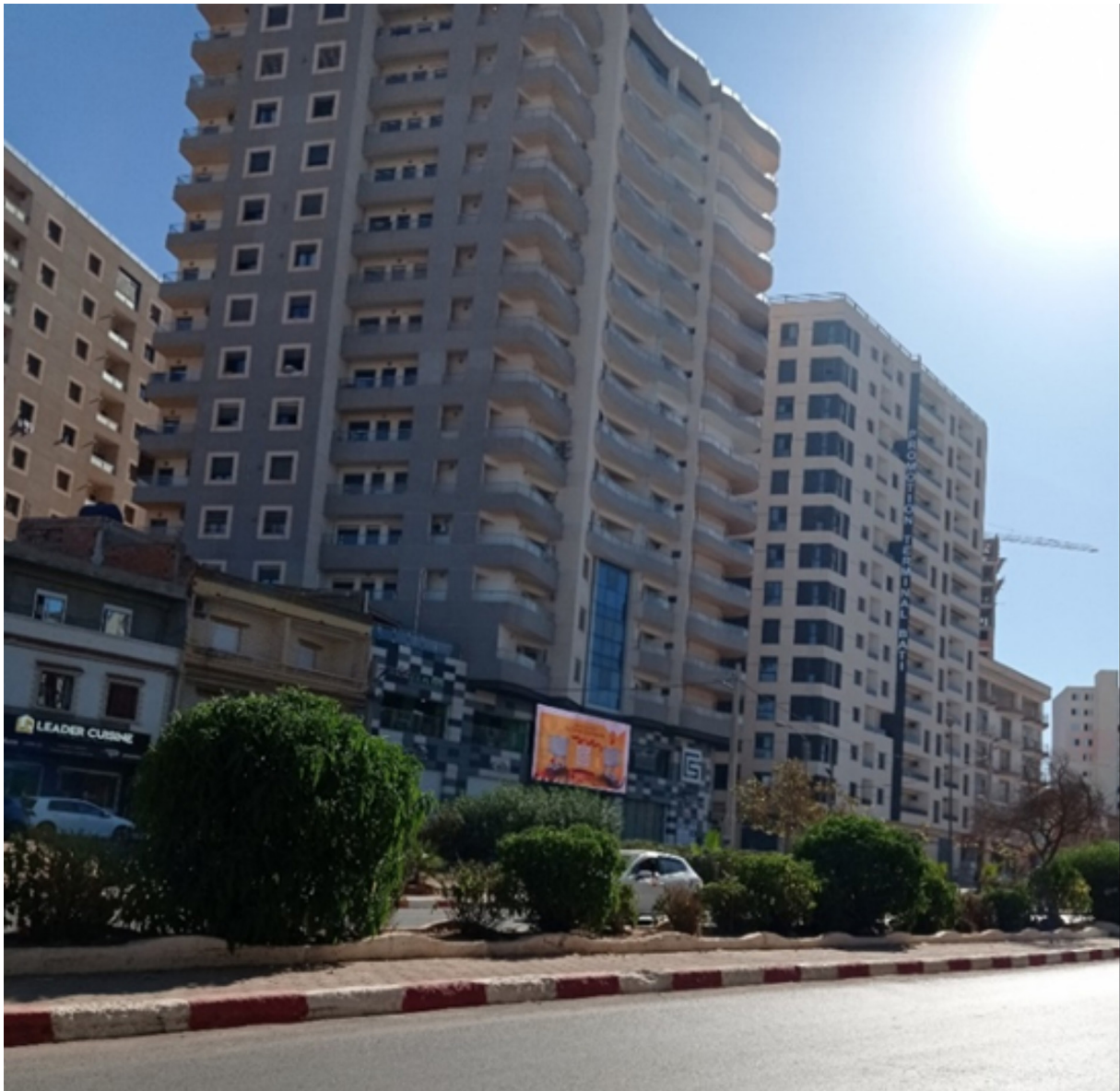
Figure 11. Les opérations de démolitions-constructions à Khemisti, les quelques habitations individuelles qui résistent à l’envahissement des tours de haut standing imposantes se trouvent encerclées (2023)
