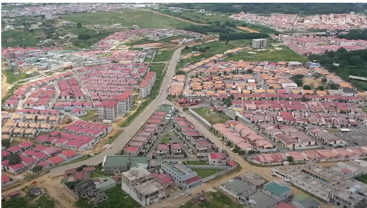
Photo 1. Vue aérienne de programmes immobiliers à Bingerville. Crédits : Radio Télévision Ivoirienne-RTI, 2023
