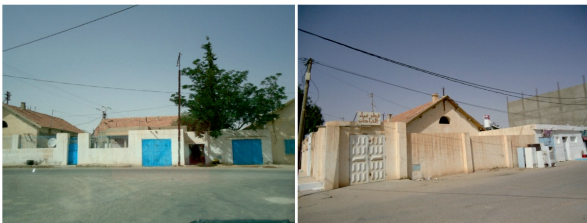
Figures 7-8. Exemples de façades à garages qui se répandent actuellement à El-Filej (Photographie de l'auteur, 2014)
