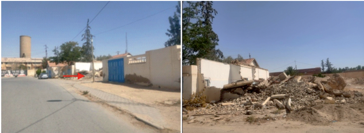
Figures 16-17. Détermination de l'espace démoli de l'hôpital d'El-Filej (Photographie de l'auteur, juin 2022)
