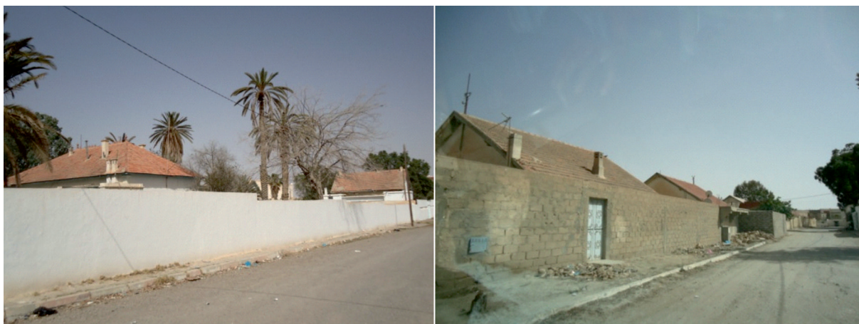
Figures 5-6. Types de clôtures supplantant actuellement celles d'origine (Photographie de l'auteur, 2014)
