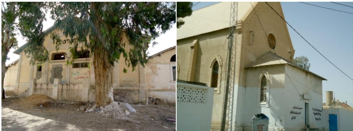
Figures 9-10. Édifices publics à protéger : l'Économat et l'Église (Photographie de l'auteur, 2014)
