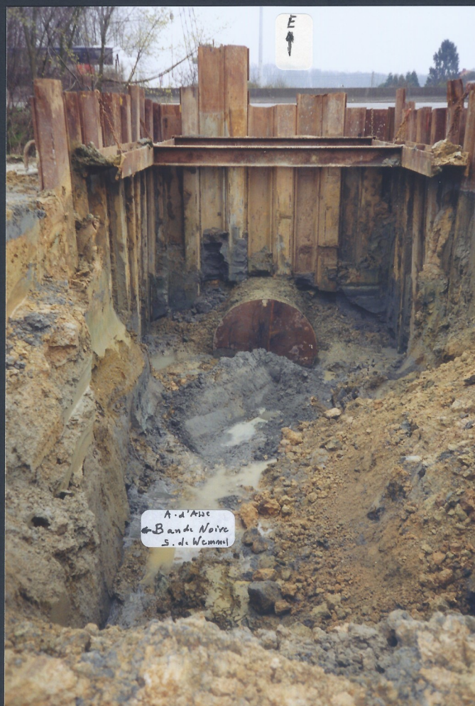
Autoroute A 12, Distrigaz, Gazoduc Brugge – Aachen, chantier ouest, mars 1998 : vues du puits. Argile d'Asse/ Glaucinite ( Bande noire ) / Sables de Wemmel. Position du prélèvement de 100 litres de sédiment in situ .
