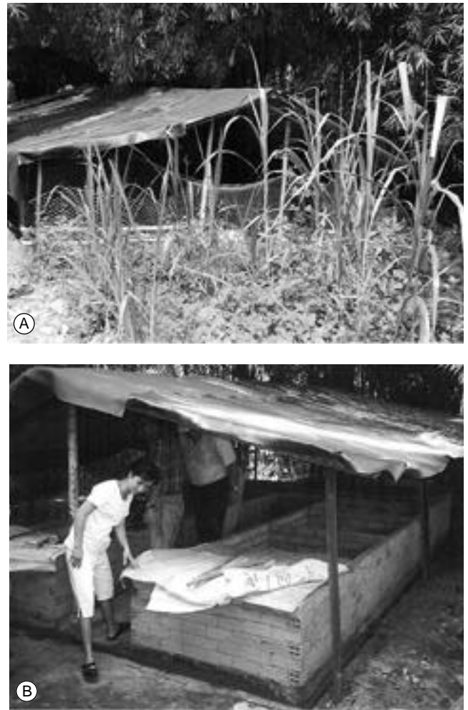
Figure 1. Vue générale de l'infrastructure (A) et représentation des unités de lombricompostage réalisées en blocs de terre cuite maçonneries (B). — General overview of the structure (A) and presentation of the vermicomposting units built in baked clay (B).
