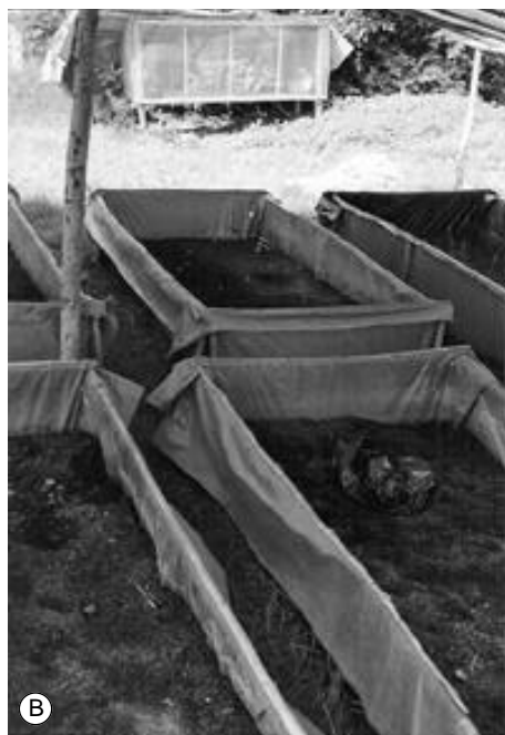
Figure 2. Vue générale de l'infrastructure (A) et représentation des unités de lombricompostage constituées d'une structure en bambou recouverte d'un film plastique (B). — General overview of the structure (A) and presentation of the vermicomposting units built in bamboo covered with plastic film (B).
