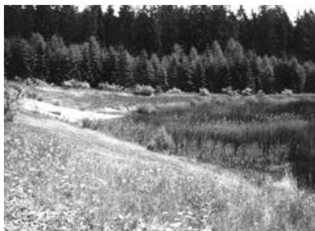
Figure 7. Cédrogne's storm water basin, Belgium — Bassin d'orage de Cédrogne, Belgique.
