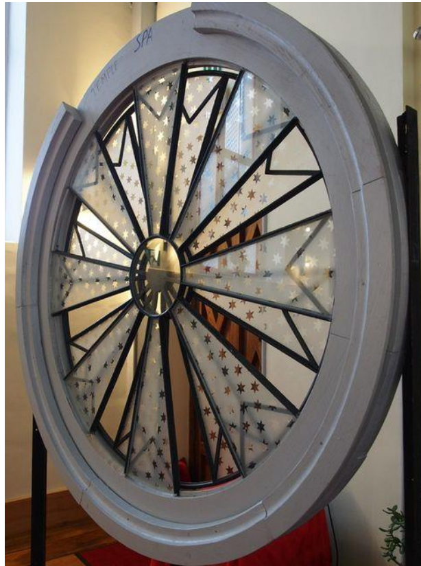
Fig. 30. La rosace à double plan de la façade du temple de l'ÉPUB à Spa, durant son exposition dans la salle de culte après sa restauration en 2018 (photo L. Druez)
