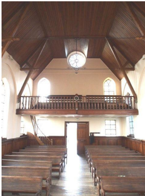
Fig. 25. L'omniprésence du bois dans le temple de l'ÉPUB à Clabecq (photo L. Druetz)
