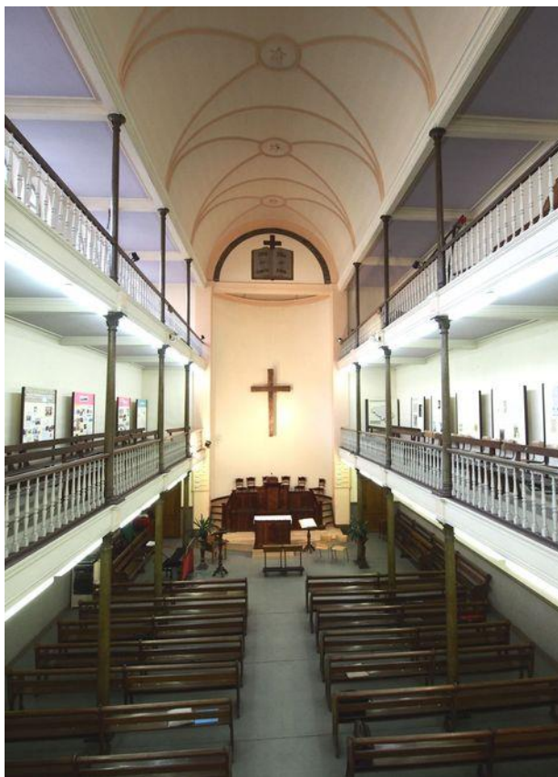
Fig. 18. La double galerie à colonnades du temple de l'ÉPUB à Charleroi (photo L. Druetz)
