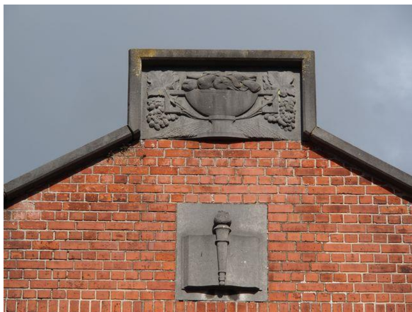
Fig. 10. Corbeille de fruits, feuilles de vignes, gerbes de blé, flambeau superposé à une Bible ouverte sculptés au sommet de la façade du temple de l'AEPEB à Soignies (photo L. Druez)
