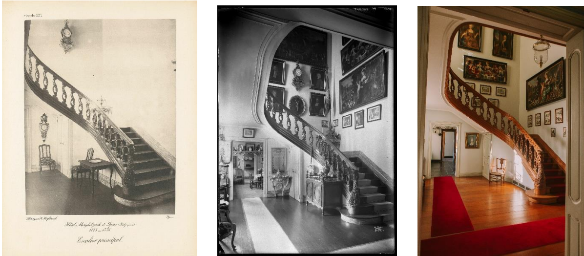
Fig. 10, 11 et 12 – Trois photos de la cage d'escalier, de gauche à droite : en 1894, en 1914 et aujourd'hui.
