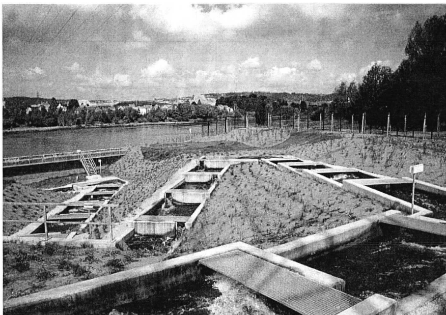
Photo 4 : vue de la récente échelle à poissons migrateurs de Lixhe-Visé View of the new migratory fish pass in Lixhe-Visé
