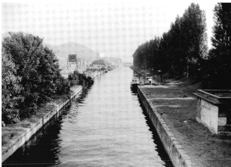
**Photo 91.** Photographie prise au même endroit, mais du pont de l'Atlas V. Le canal s'élargit à Coronmeuse et débouche dans ce qui était le bassin de manoeuvre, dont l'essentiel a été remblayé. Le canal est aujourd'hui à la cote 60 maintenue par le barrage de Monsin (septembre 1994).
