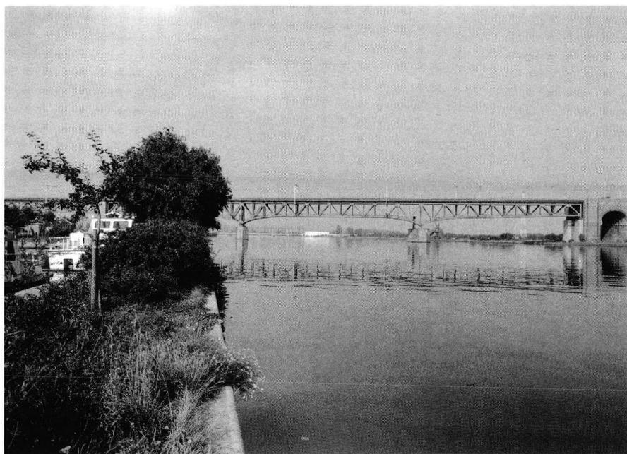
**Photo 137.** La Meuse canalisée, le pont-rails modernisé et électrifié et, tout au fond, le pont barrage moderne de Lixhe, qui a créé un vaste plan d'eau ; les îles et le vieux barrage ont disparu ; à gauche, le canal de jonction. Septembre 1994.
