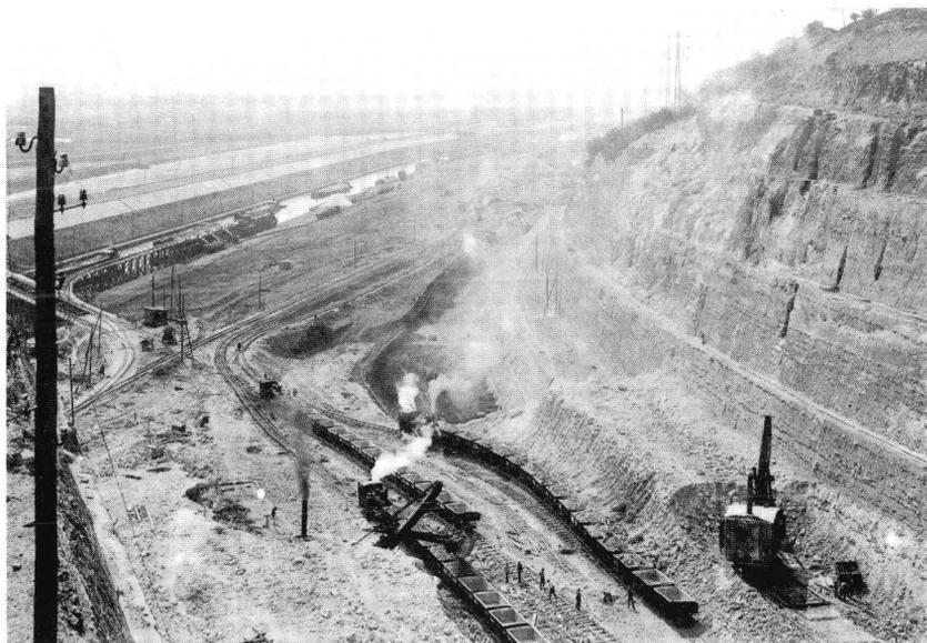
**Photo 2.** En 1930, sur le site de Lanaye, la construction du canal Albert amène le percement d'une imposante tranchée à travers le massif de Caster.
