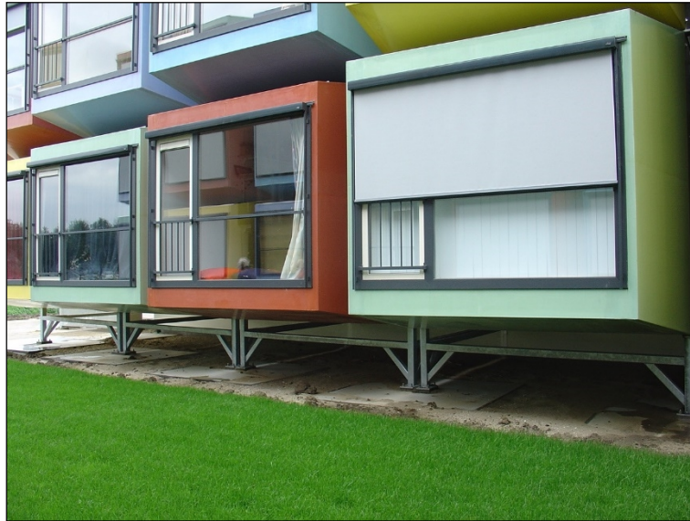
Figure 24. Construction modulaire à Utrecht
