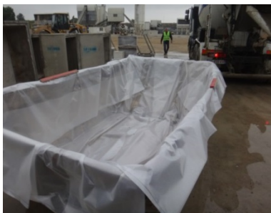
J-0 Coulage – bennes de 4 m 3
